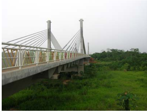
Figura 1. Puente internacional entre Assis Brasil (Acre, Brasil) e Iñapari (Madre de Dios, Perú) en el corazón de la Amazonia. Una conexión que es parte de la “Estrada do Pacífico” que conecta el centrooeste de la Amazonia de Brasil con Perú y los puertos en el Océano Pacífico. Foto E. Gudynas, noviembre 2007.
